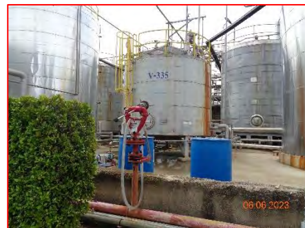
ภาพที่ 2.1-32 Fixed Foam Monitor บริเวณถังเก็บฟอร์มาลดีไฮด์
