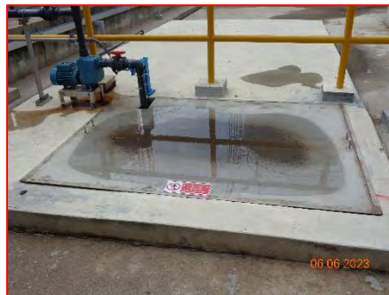
ภาพที่ 2.1-17 บ่อรองรับน้ำฝนปนเปื้อน
