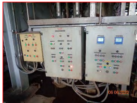
ภาพที่ 2.1-4 จอแสดงผล (Display) ของระบบควบคุม Scrubber
