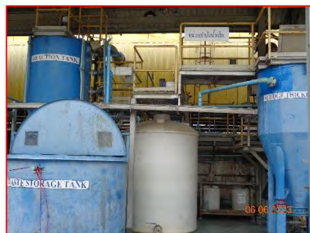
ภาพที่ 2.1-6 ระบบบำบัดน้ำเสียเบื้องต้น
