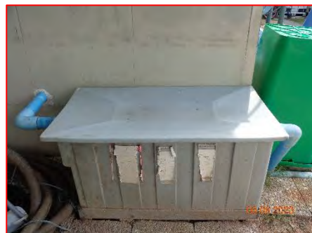
ภาพที่ 2.1-6 ระบบบำบัดน้ำเสียเบื้องต้น
