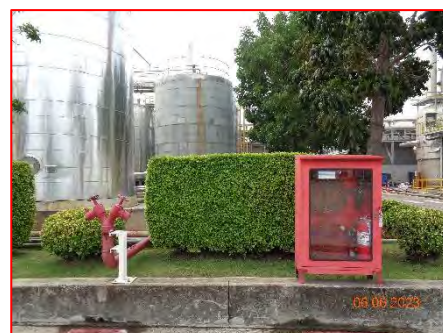
ภาพที่ 2.1-34 ระบบดับเพลิงบริเวณคั่นคอนกรีตรอบถังเก็บ ฟอร์มาลดีไฮด์
