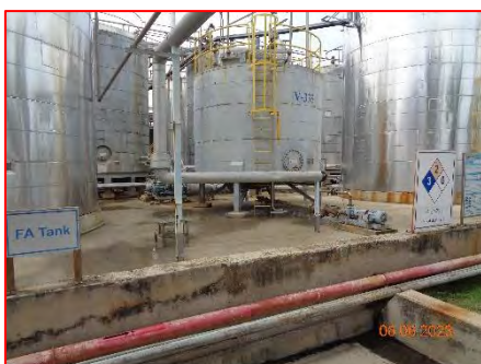
ภาพที่ 2.1-33 คั่นคอนกรีตรอบถังเก็บฟอร์มาลดีไฮด์
