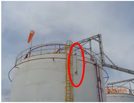
ภาพที่ 2.1-35 Temperature and Level Detector และ Temperature and Level Alarm
